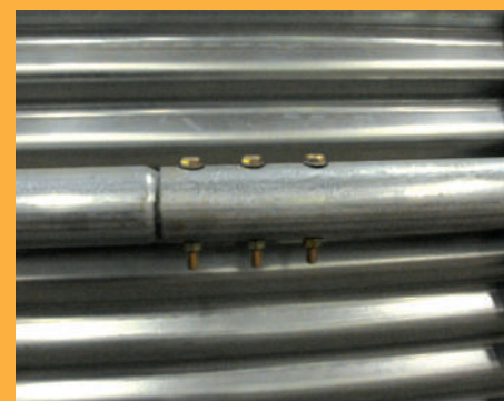
Соединение встык, зафиксированное болтами
