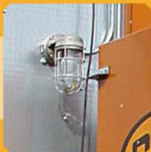
**5** Рабочее освещение, используемое также как индикатор завершения работы.
