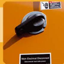
**15** Необслуживаемый безопасный выключатель вмонтирован в дверную ручку для безопасности, экономичности установки и ухода.
