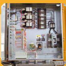
**9** Контакторы, прерыватели и перегрузочные реле промышленного класса, соответствующие стандарту IEC, гарантируют долговечность и качество, а вспомогательные загрузочные и разгрузочные контакторы помогают уменьшить затраты на установку.
